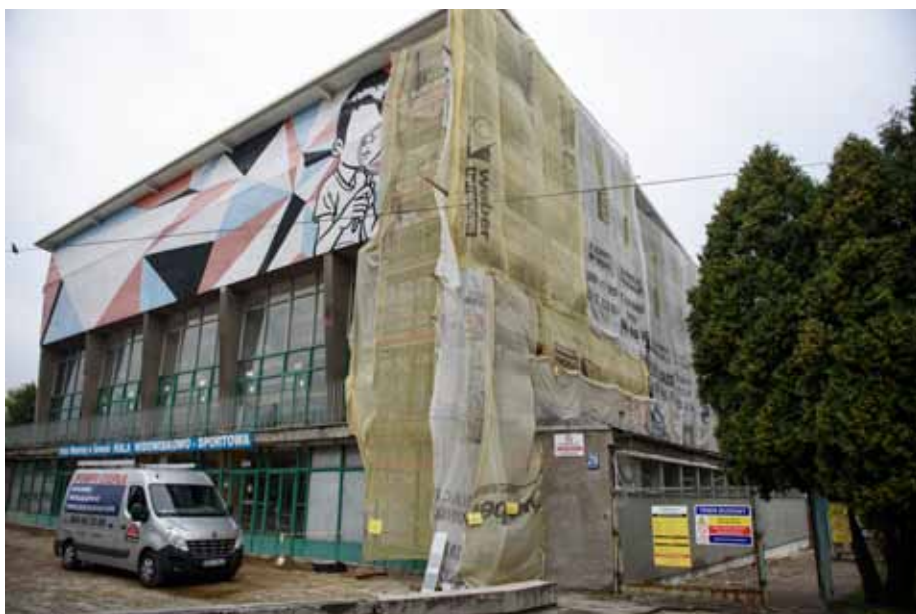
Przy ul. Gumniskiej trwają prace związane m.in. z dociepleniem hali sportowej.
