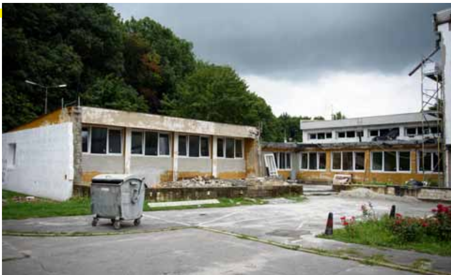
Budynek hali sportowej przy ulicy Chemicznej ma być gotowy pod koniec marca przyszłego roku.
